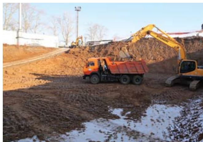
Котлован для смесителя хозяйственно-бытового и химического стоков (февраль 2016 года)
