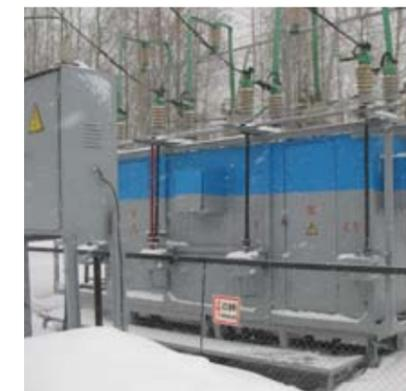
Пост секционирования с устройством защиты от наведенного напряжения
